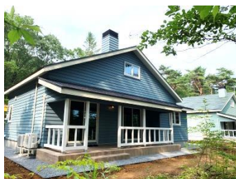
外観（左A棟・右B棟）
